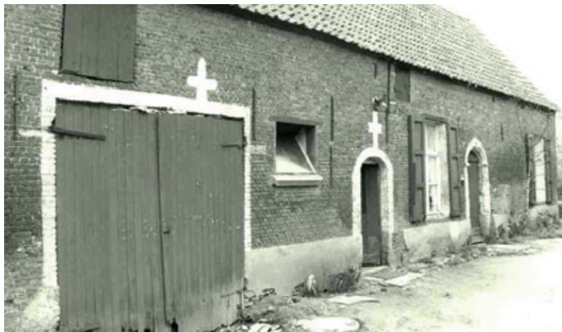
39 / Afweerkruisen bij een langgevelhoeve in de Donkereweg in Ranst. Ook een van de kelderraampjes had een kruis.
